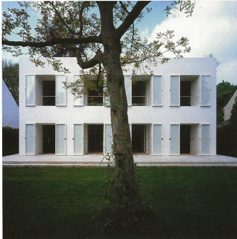
Haus Kämpchensweg, Ansicht vom Garten mit geöffneten Fenstern
